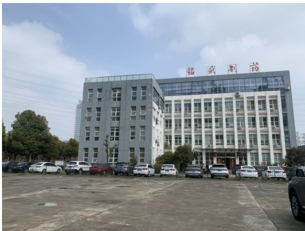
图 4-1 1#厂房场地现状
